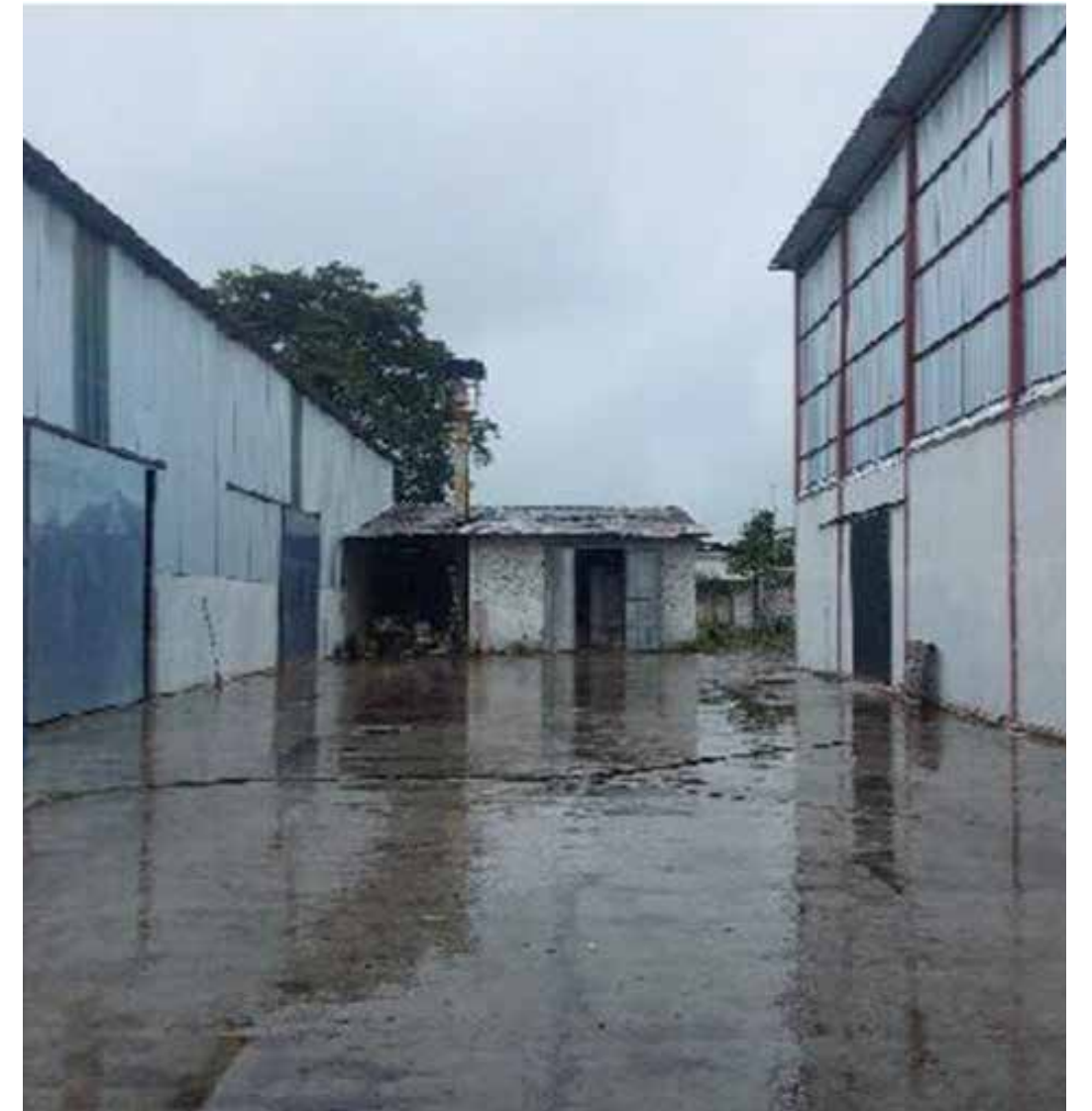
VISTA DE PATIO INTERIOR
