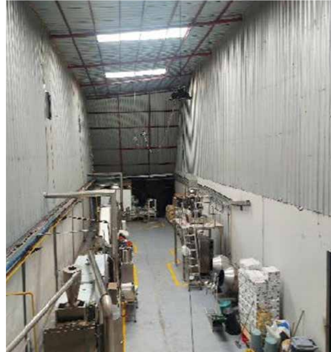
VISTA INTERIOR DE GALPÓN 1
