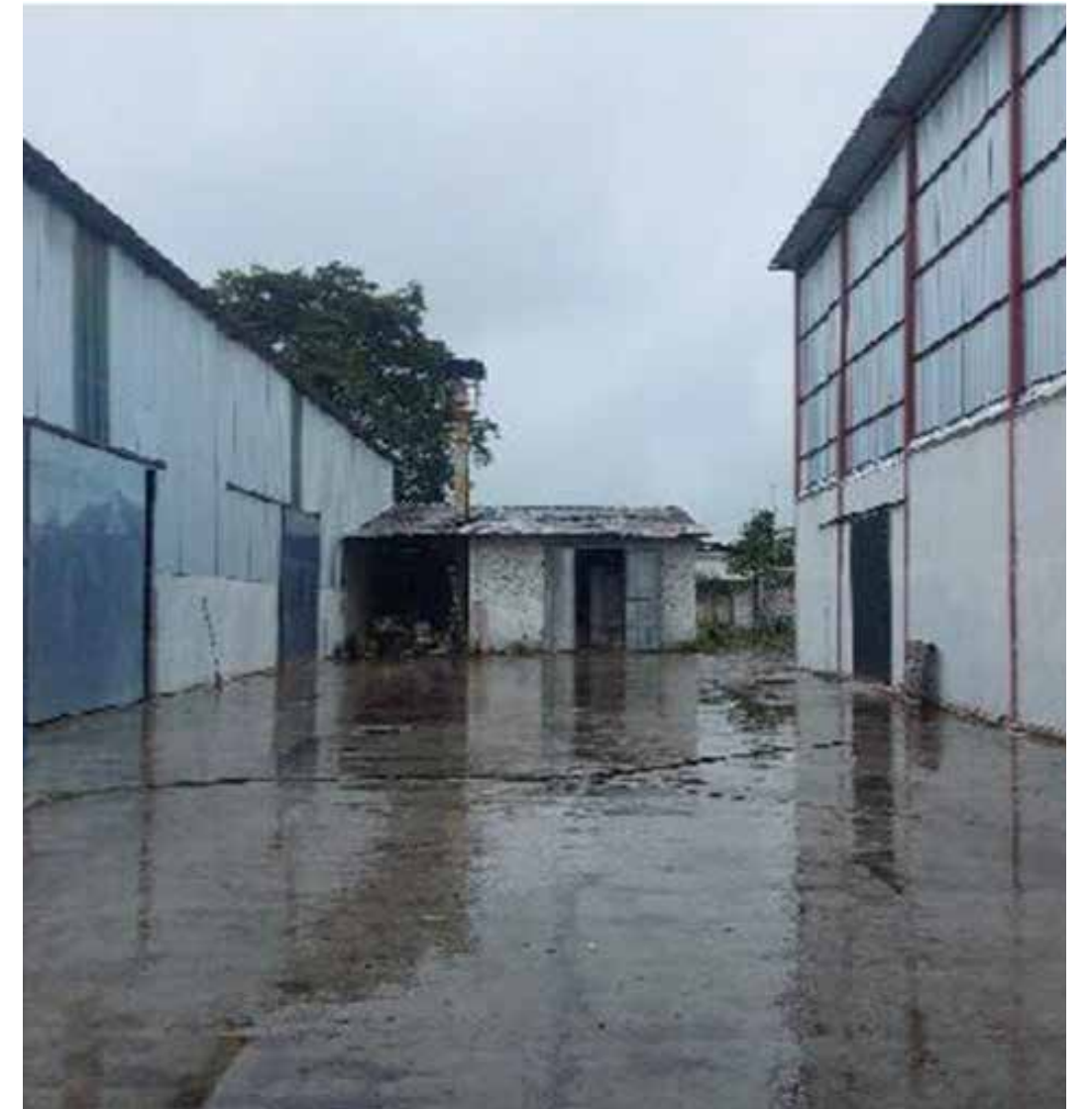
VISTA DE PATIO INTERIOR
